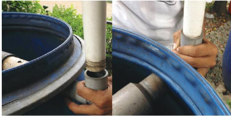
Gambar 6.15 Penyambungan cerobong udara
